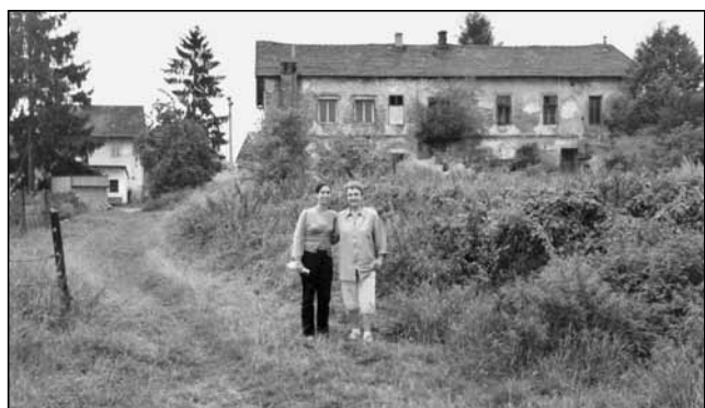
Pohled na zchátralou budovu hospody Na Fojtství před demolicí, foto z r. 2003
